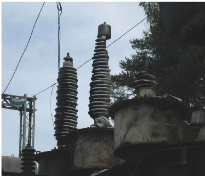
Рис. 9.74. Повреждение оборудования ПС при ударе молнии
