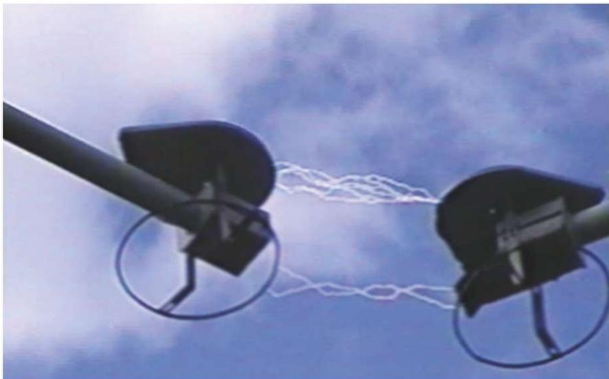
**Рис. 1.12. Коммутация разъединителем на ОРУ 330 кВ**
