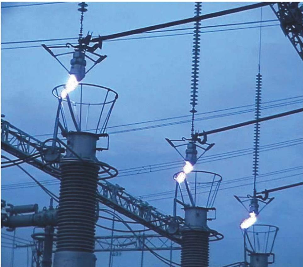
**Рис. 1.11. Коммутация разъединителем на ОРУ 500 кВ**
