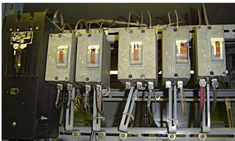
Рис. 4.57. Автоматические выключатели распределительных линий ЩПТ со сломанными органами управления (крайние слева и справа)
