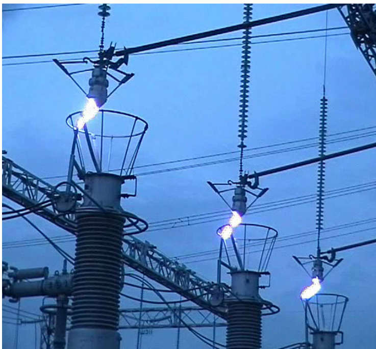
Рис. 3.7. Коммутация разъединителем на ОРУ 500 кВ
