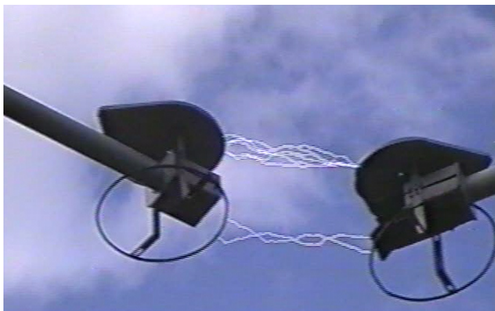
Рис. 3.8. Коммутация разъединителем на ОРУ 330 кВ
