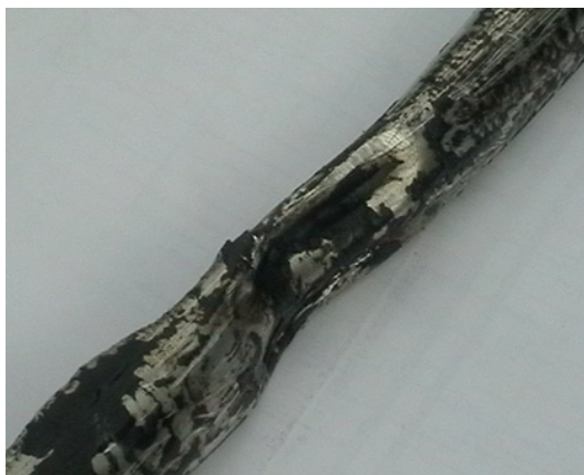
Рис. 2.6. Перекрытие на кабель с заземляющего устройства молниеотвода
