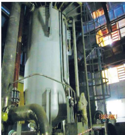
Рис. 3.13. Схема конструкции и внешний вид патронных фильтров на Калининской АЭС
