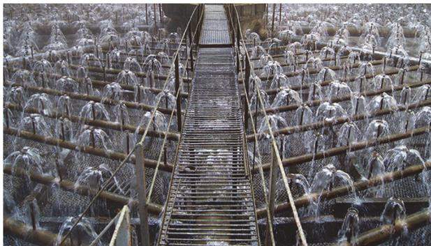
**Рис. 17.8. Водораспределительная система с разбрызгивающими соплами**
