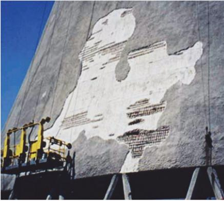
**Рис. 17.17. Разрушение поверхности бетонной оболочки градирни в результате карбонизации**
