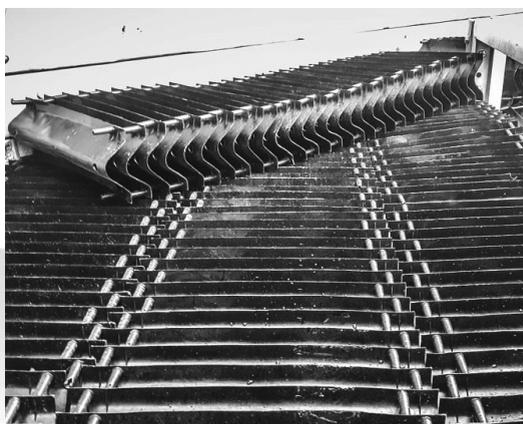
**Рис. 17.14. Монтаж панелей каплеуловителя**
