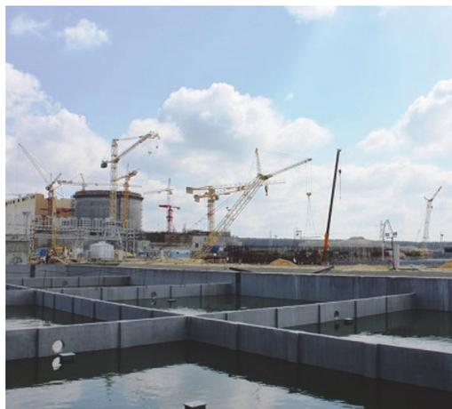
Рис. 17.5. Брызгальный бассейн Нововоронежской АЭС-2 (вид на секции)
