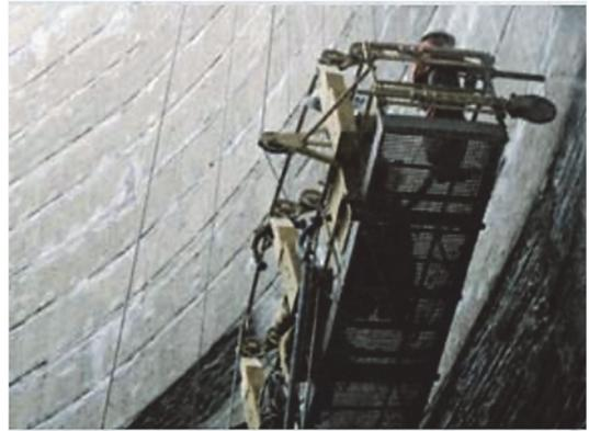
**Рис. 17.18. Торкретирование внутренней поверхности градирни**
