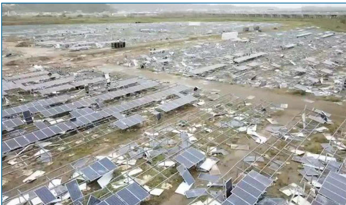
Рис.75. Разрушение солнечной фермы в Пуэрто-Рико
