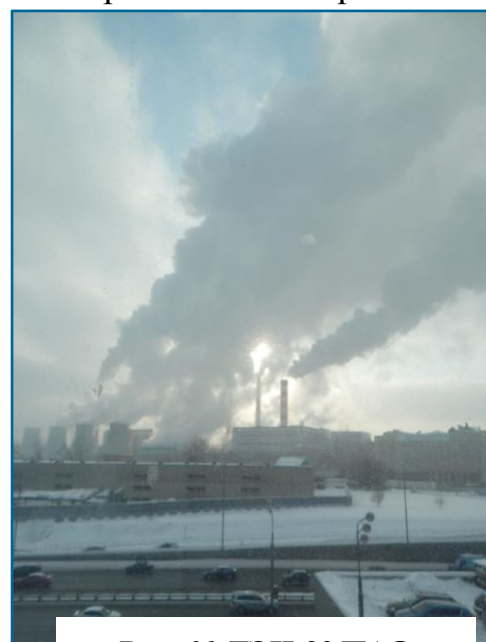
Рис. 66. ТЭЦ-20 ПАО «Мосэнерго», г. Москва
