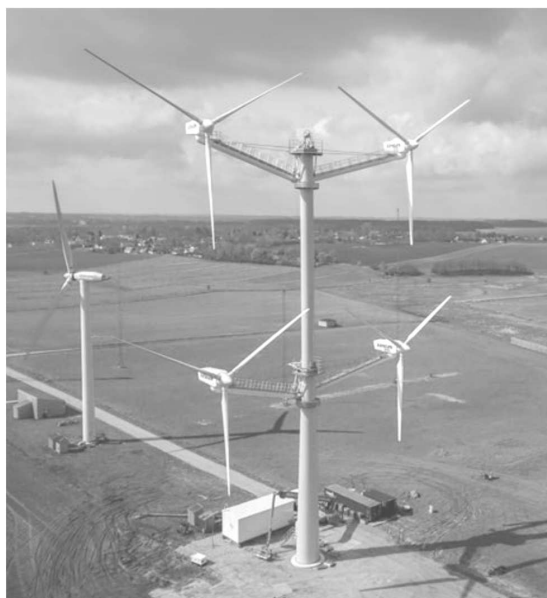
Рис. 2.22. Экспериментальная ВЭУ Vestas 900 кВт, расположенная на испытательном полигоне в Рисе, Дания
