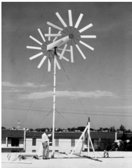
Рис. 2.16. Изобретатель с прототипом без редукторной ВЭУ мощностью 2 кВт с двумя вращающимися ВК
