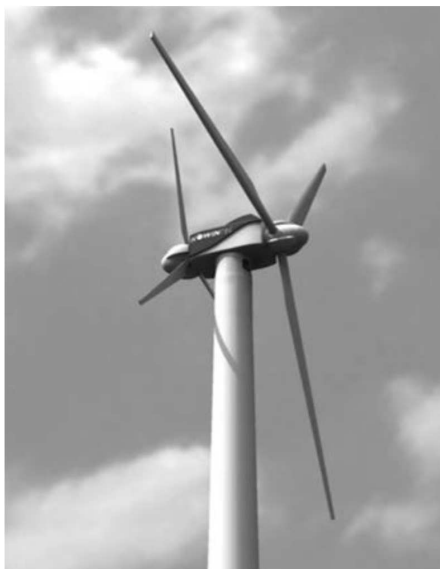
Рис. 2.17. ВЭУ UWinSys (Kowintec) мощностью 1 МВт, диаметр переднего ВК – 25 м, подветренного ВК – 47 м, высота башни – 45 м
