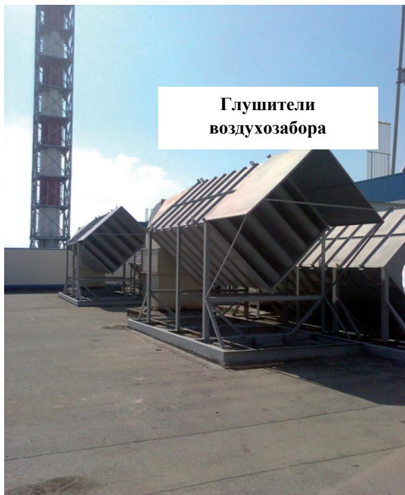
Рис. 10.27. Размещение глушителей систем вентиляции кожуха ГТУ на крыше станции:
