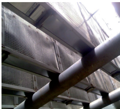
Рис. 10.19. Глушитель шума в котле утилизаторе
